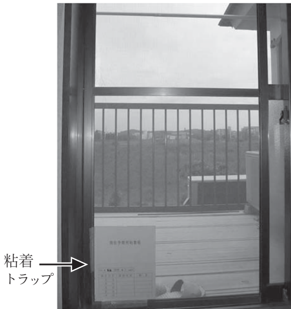
図4 実試用環境（一般住宅）での侵入抑制効果評価における網戸設置状況
